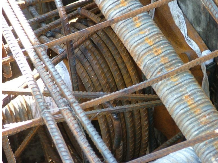
螺旋钢筋采用螺纹钢筋，且螺距过小或过大
