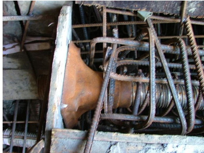
螺旋钢筋采用螺纹钢筋，且螺距过小或过大
