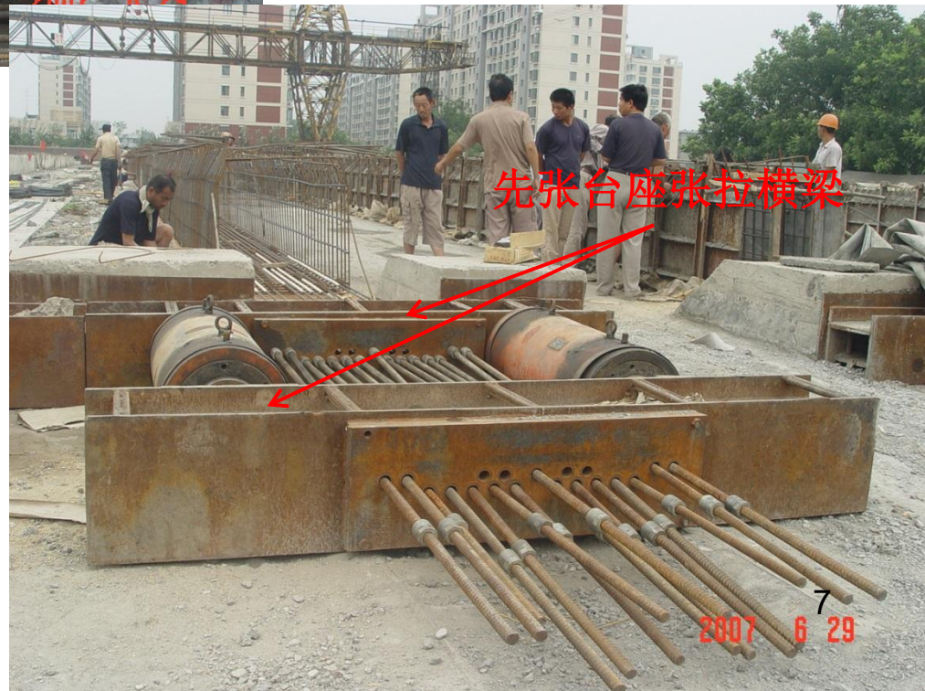
先张台座压杆支撑及张拉横梁
