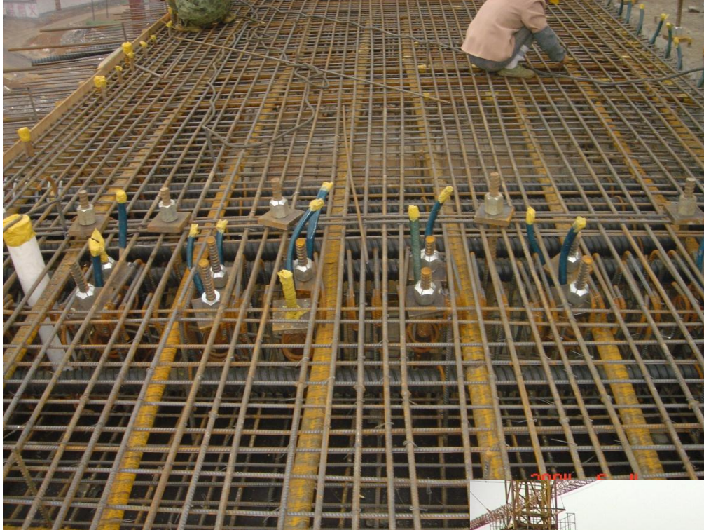
横向扁波纹管、竖向管道 及排浆孔
