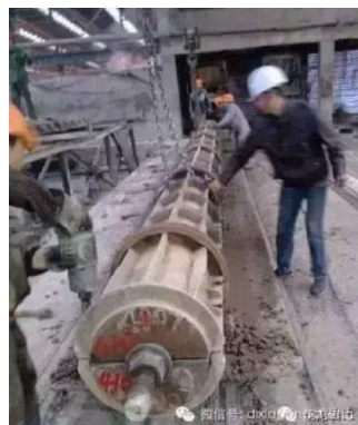
安装上部模板
