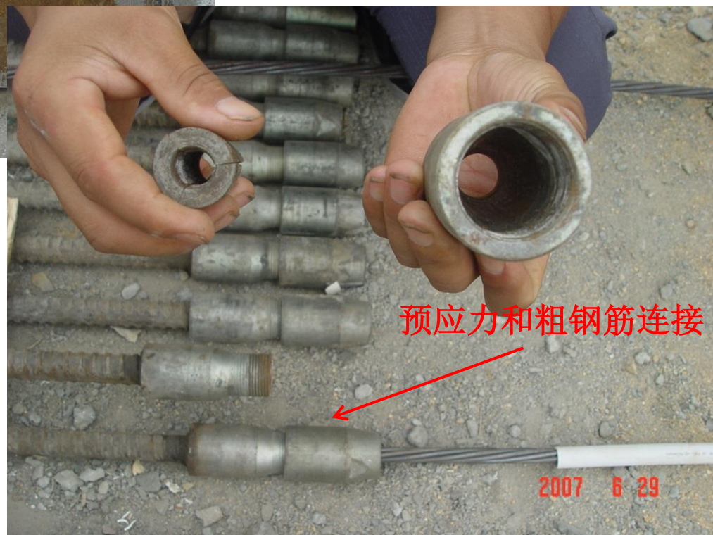
先张台座张拉横梁及钢绞线和粗钢筋连接方式
