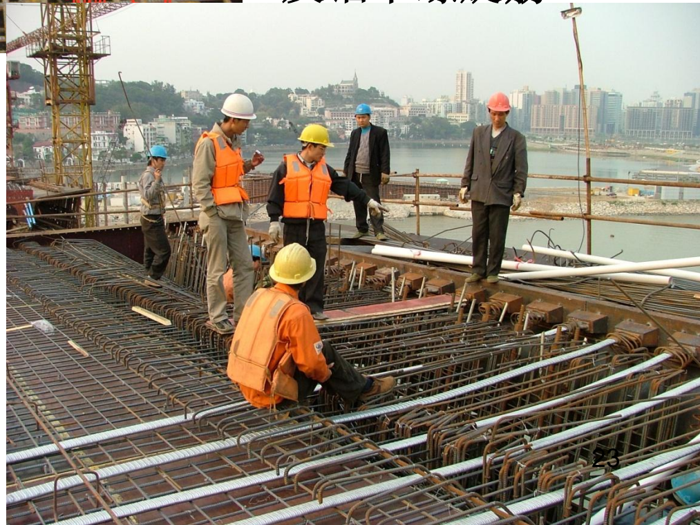
横向扁波纹管 及锚下螺旋筋
