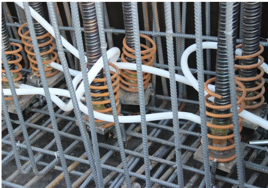
波纹管竖向孔道
